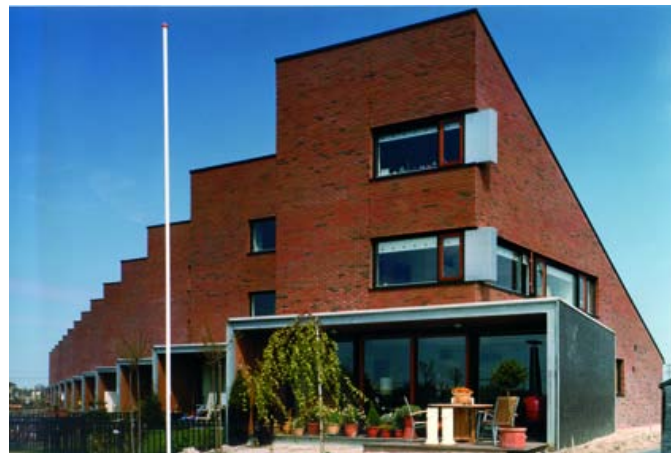
Figuur 5.24 Pierwoningen, Zuiderburen
