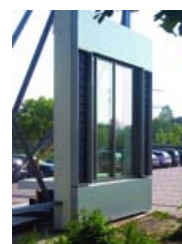
Figuur 6.17 Mockup van de gevel van de kantoren
