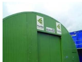
Figuur 6.20 Loods met daarin de mockup van de laboratoriumgevel
